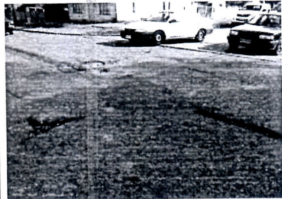
Fotografía N° 26 – 6/03/2015: Reparación de baches de calle Almirante Simpson.
