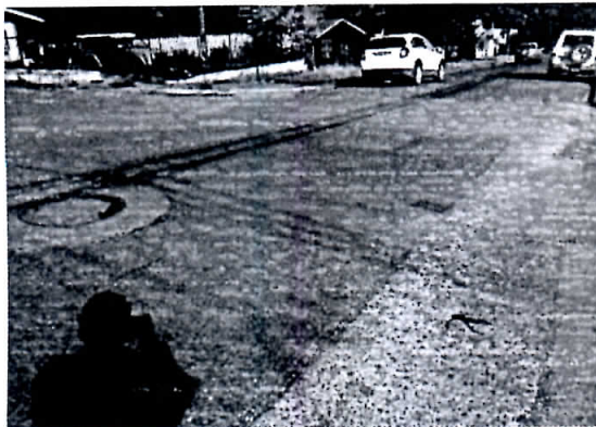
Fotografía N° 27 – 6/03/2015: Reparación de baches de calle Almirante Simpson.
