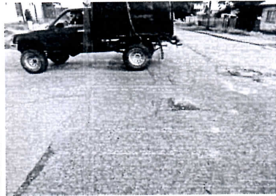
Fotografía N° 24 – 6/03/2015: Reparación de baches de calle Almirante Simpson.
