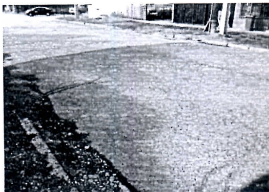
Fotografía N° 23 – 6/03/2015: Reparación de baches de calle Almirante Simpson.
