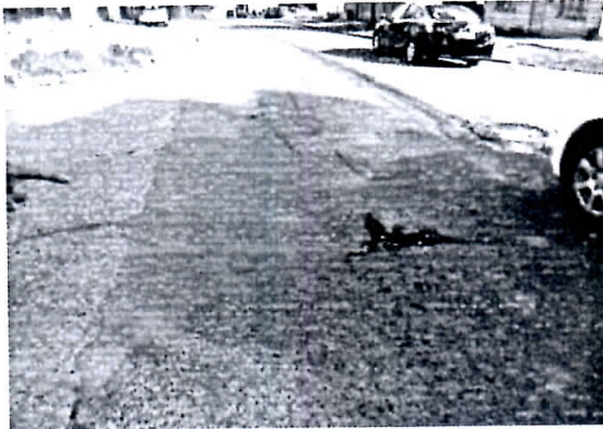
Fotografía N° 25 – 6/03/2015: Reparación de baches de calle Almirante Simpson.
